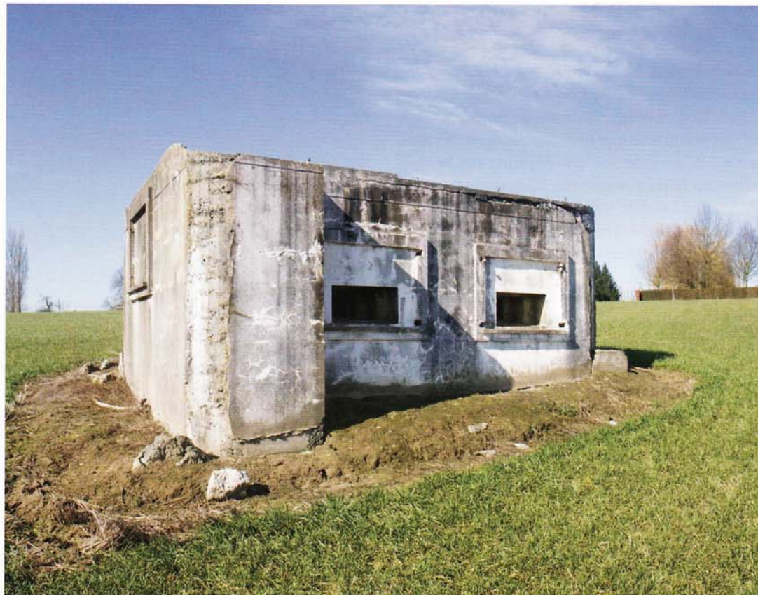
► Mitrailleurbunker Av4 met twee kamers (foto O. Pauwels)
