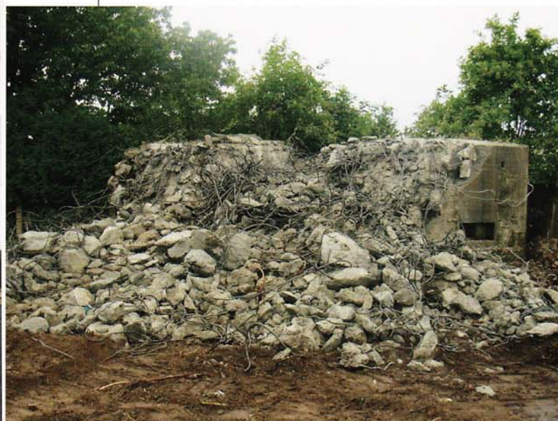
◀ De afbraak van bunker AVI (foto Bunkergordel)
