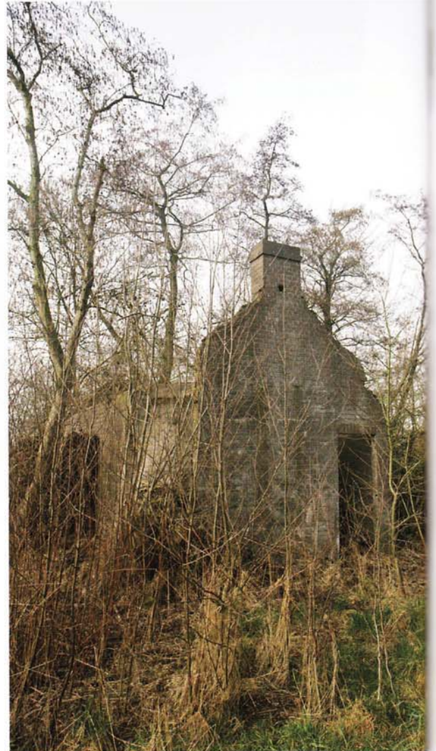
▲ Bunker D2 gecamoufleerd als huis (foto O. Pauwels)
