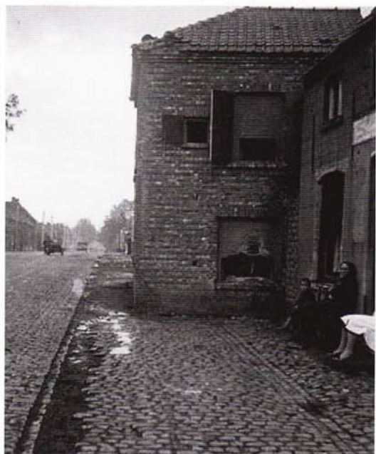
▼ Zware bunker S8 te Kwatrecht, gecamou- fleerd als rijhuis (foto Replica)
