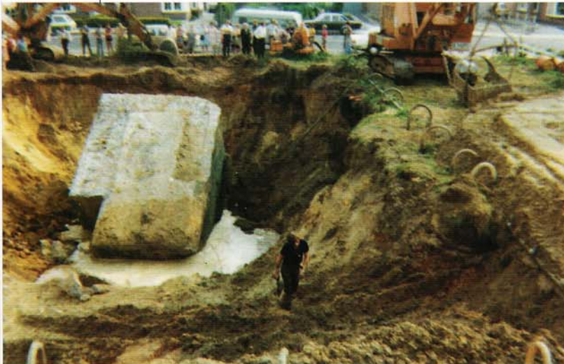
▼ Ondergraving van bunker D3 (foto L. Meysman)
