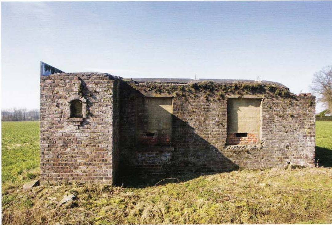
◀ Bunker Av8, gecamoufleerd met baksteen. Een kapelletje is ingemetseld in het oreillon (foto O. Pauwels)
